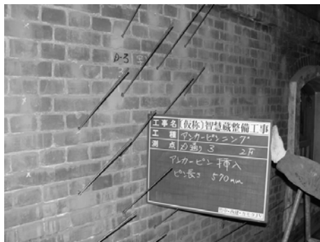
図1 ステンレスピン挿入
