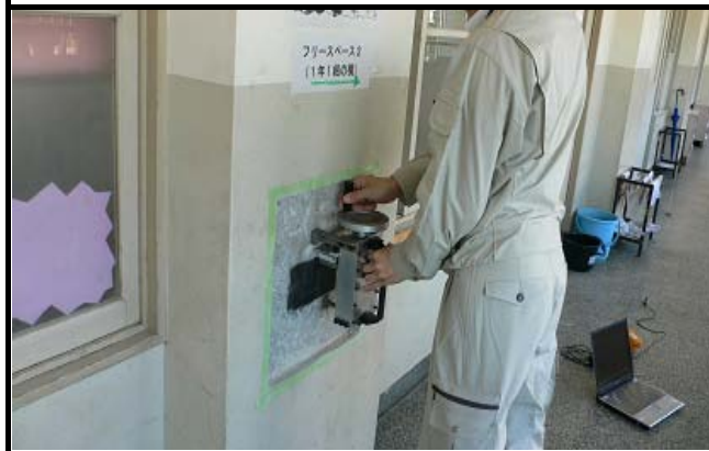
写真No. 7 (写真向き ↑) 引っかけ傷法 柱 『引っかい太郎』による引っかけ試験状況
