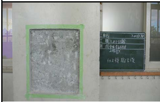
写真No. 6 (写真向き ↑) 引っかけ傷法 柱 仕上げ材撤去後
