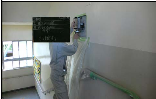
写真No. 3 (写真向き ↑) 引っかけ傷法 壁 『引っかい太郎』による引っかけ試験状況
