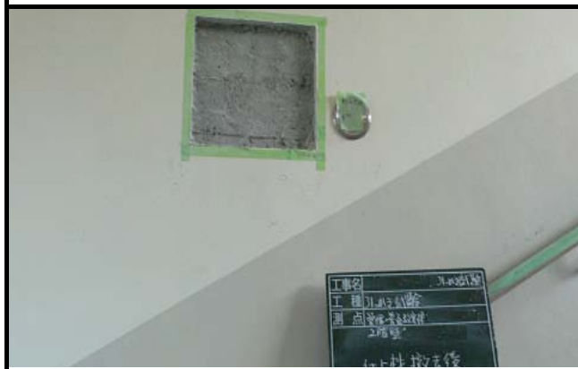
写真No. 2 (写真向き ↑) 引っかけ傷法 壁 仕上げ材撤去後
