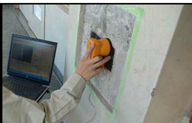
写真No. 8 (写真向き ↑) 引っかけ傷法 柱 『測ってみタロー』による引っかけ傷幅測定状況
