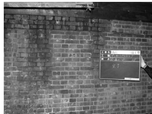
図-2 ステンレスピン挿入後
