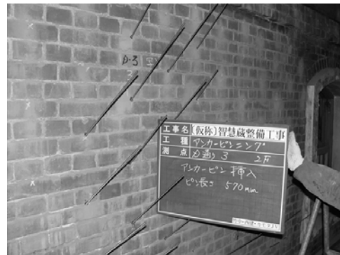
図-1 ステンレスピン挿入時
